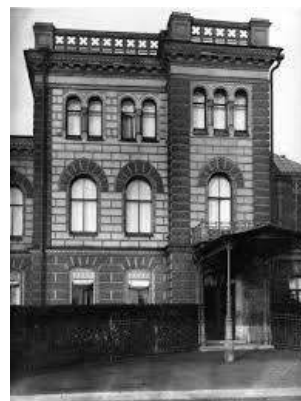
Рисунок 2. Особняк и заводоуправление Механического завода "Людвига Нобель" вход Figure 2. Mansion and plant management mechanical plant "Ludwig Nobel" entrance
