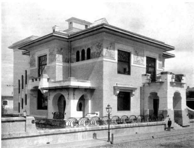
Рисунок 1. Особняк Рябушинского, фотография начала XX века Figure 1. Ryabushinsky mansion, photograph of the beginning of the twentieth century
