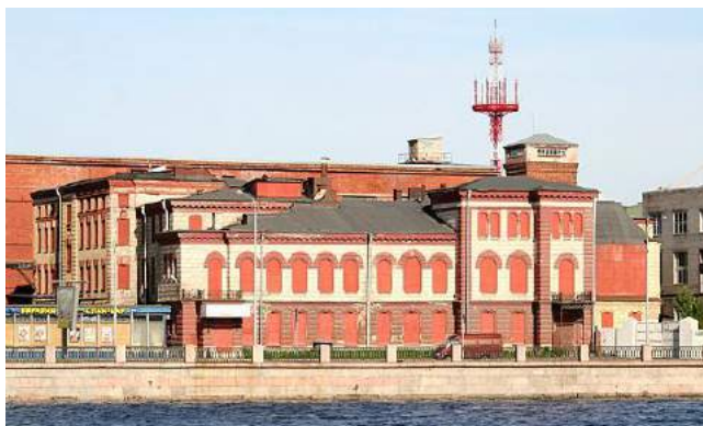
Рисунок 3. Здание внешний вид Figure 3. Building appearance
