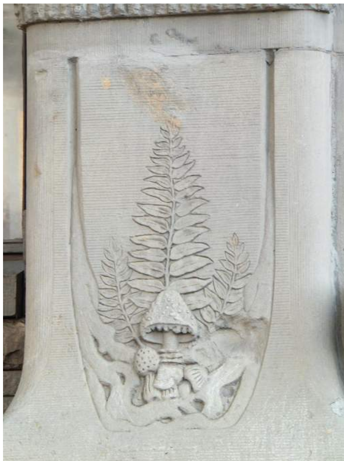
Рисунок 9. Грибы и листья папоротника в декоре фасада доходного дома семьи Лидваль на Каменноостровском пр., 1-3 Figure 9. Mushrooms and fern leaves in the decor of the facade of the Lidval family apartment building on Kamennoostrovsky pr., 1-3
