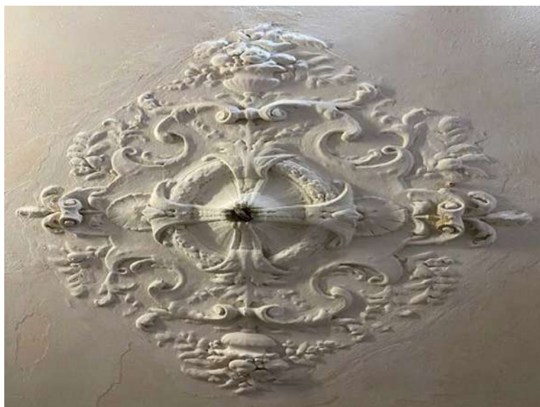
Рисунок 2. Плафон (лепнина на потолке, г. Санкт-Петербург, 8-я Красноармейская, д.14)
