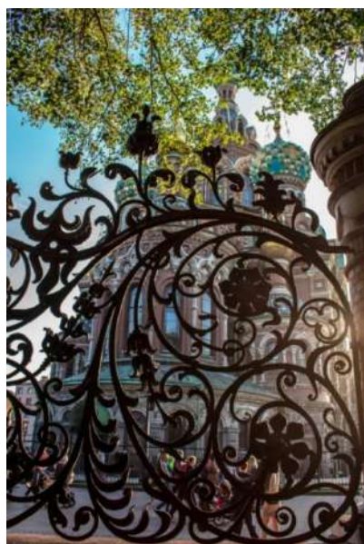
Рисунок 4 – Кованый рисунок орнамента растительных форм: цветочные мотивы с переплетениями листьев и стеблей . Ограда Михайловского сада. 1903-1907. Проект архитектора А.А. Парланда, художественно-строительно-слесарный завод К.И. Винклера
