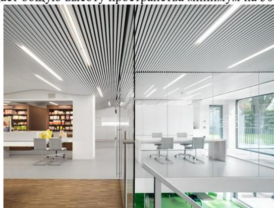
Рис. 2. Потолок из металлических реек
