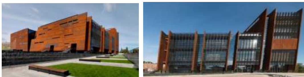
Рисунок 5. Южный и западный фасады ECS, покрытые кортеновскими плитами толщиной 5 мм.
